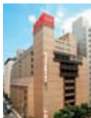
本社・大阪1号館 (装いの館) 〒541-0056大阪府中央区 久太郎町二丁目1番5号 TEL.06-6262-0303 (代表) 土地面積 3,368㎡ 延床面積 31,370㎡
