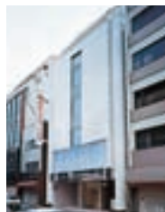
東京店 〒103-0003東京都中央区 日本橋横山町6番地16号 TEL.03-3668-0103(代表) 土地面積 384㎡ 延床面積 2,339㎡
